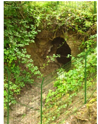
Photomontage d'installation d'un périmètre grillagé à l'entrée de la carrière souterraine de Mâlain en Côte-d'Or (entité 21.2).
