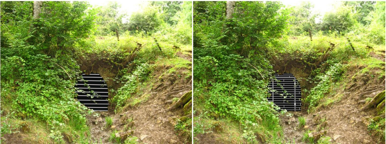
Photomontages d'installation d'une grille et d'une grille-porte à l'entrée de la carrière souterraine de Mâlain en Côte-d'Or
