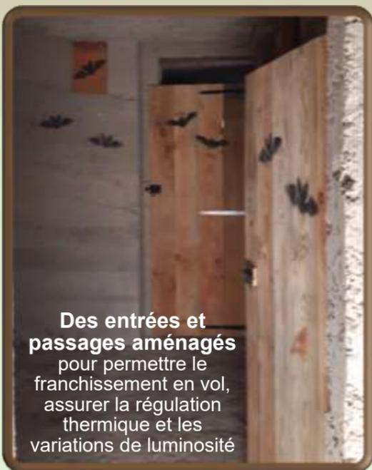
Des entrées et passages aménagés pour permettre le franchissement en vol, assurer la régulation thermique et les variations de luminosité
