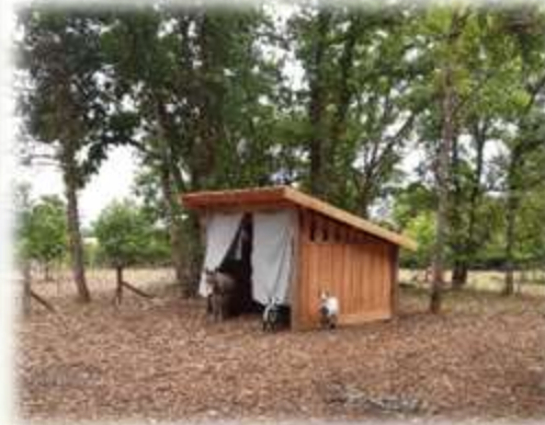
Équipement pastoraux : construction d'un abri pour les animaux - Sylvain Gillot
