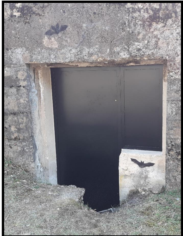
Figure 7 : Fermeture entrée (côté extérieur) – ©E. Burlotte
