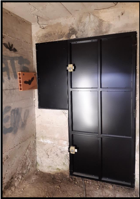
Figure 6 : Fermeture entrée (côté intérieur) - ©E. Burlotte
