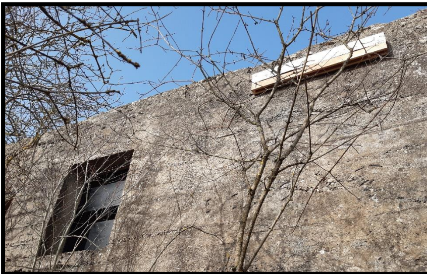
Figure 18 : Gîtes 15 - façade extérieure - ©E. Burlotte
