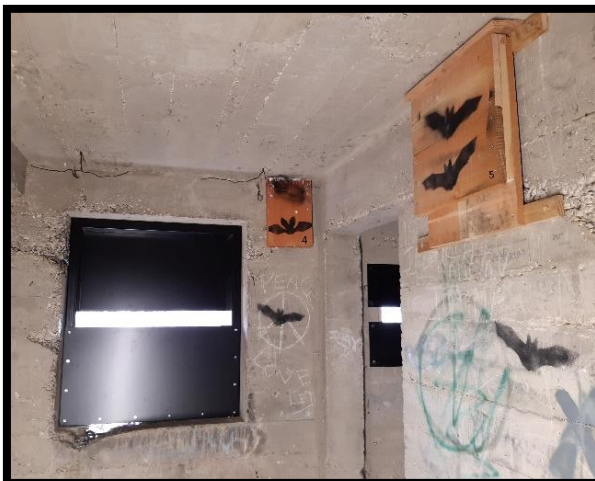
Figure 11 : Gîtes 4 et 5 - couloir - ©E. Burlotte
