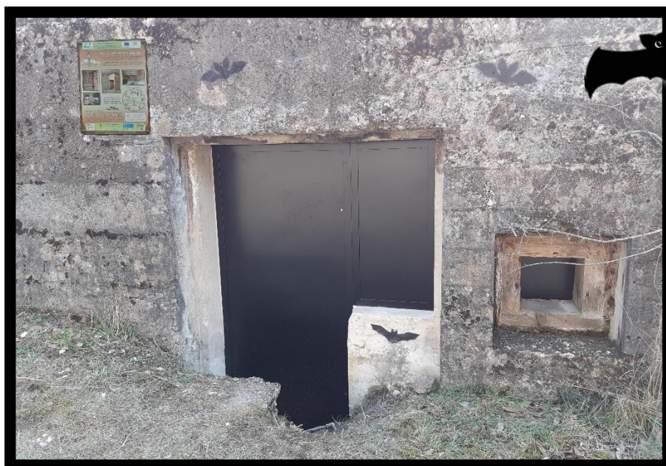
Figure 1 : Blockhaus après travaux, côté route - © E. Burlotte
