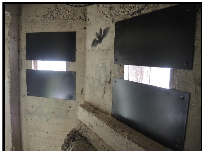
Figure 3 : Fermetures : Fermeture des petites ouvertures 'Chiroptières' côté Yonne (intérieur) - ©A. Cartier
