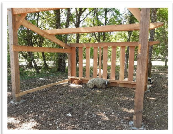
Figure 5 : Abri en construction, déjà occupé !
