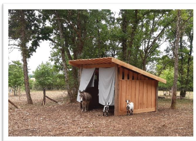
Abri finalisé, occupants satisfaits
